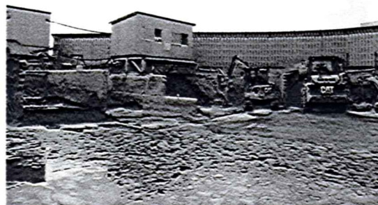
写真-5 4年がかりで約220mの防音壁を設置
