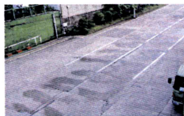
写真-1 工場内路面散水
